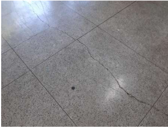
Piso trincado
