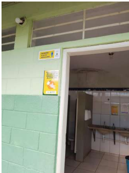
Identificação banheiro masculino
