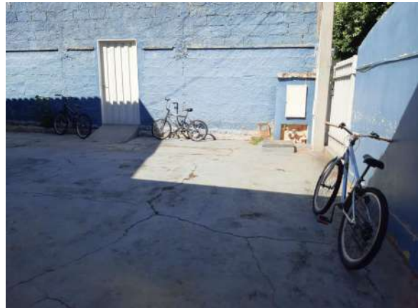
Ausência de bicicletário - entrada 5º ano
