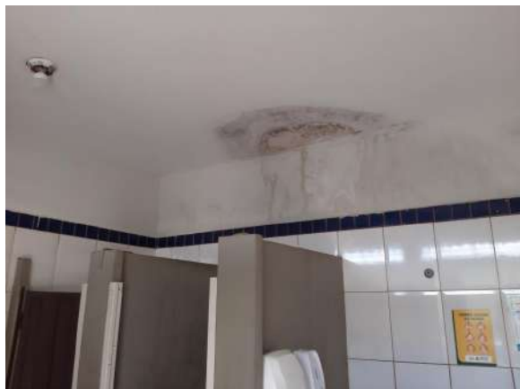
Mofo/infiltração
