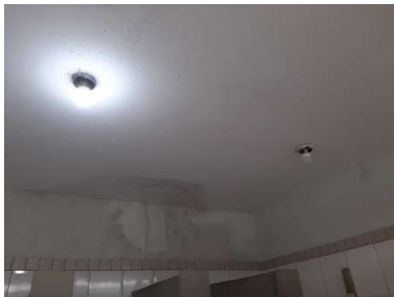
Mofo/infiltração
