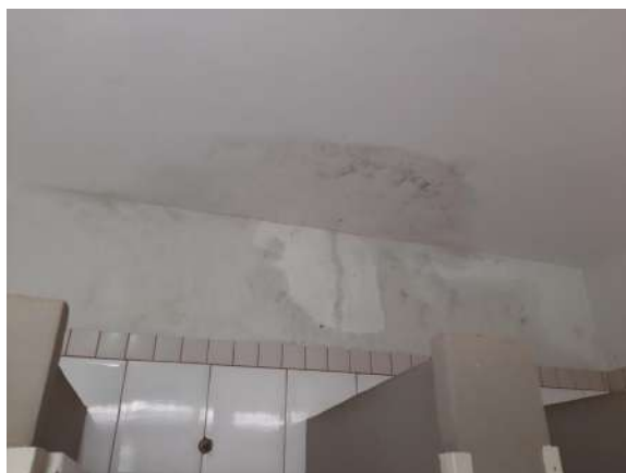
Mofo/infiltração
